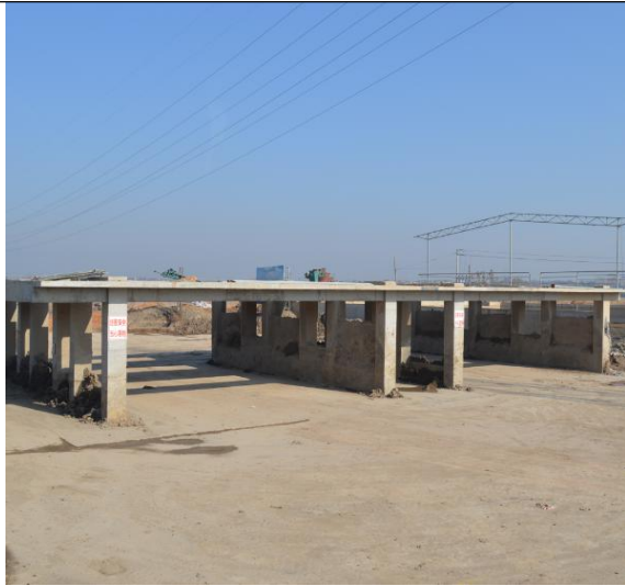
干化场器械拆除（2017 年 12 月）
