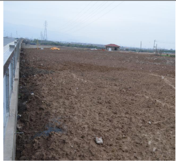
干化场覆土（2018 年 3 月）
